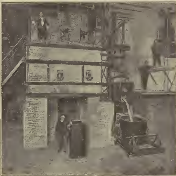
Fig. 2. — Alto horno eléctrico para la fabricación de acero en Sivet
